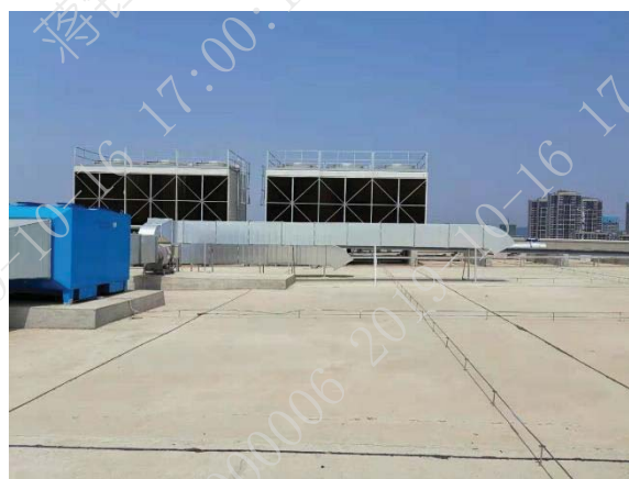
活性炭处理装置及排气筒（6#~9#一致）
