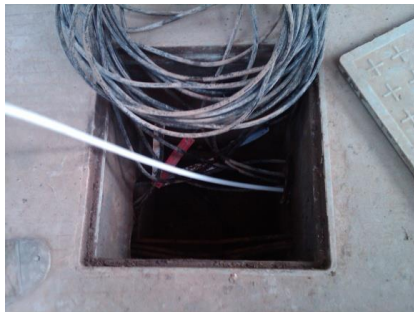
a. 一楼楼道处手井
