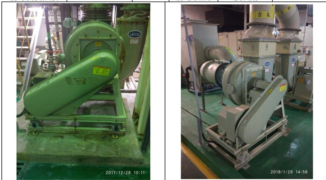
图 4-5 减震器（弹簧）、软连接照片
