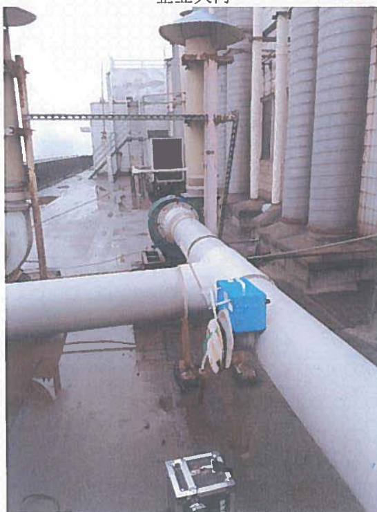
氯-1 排气筒出口(©2#)
