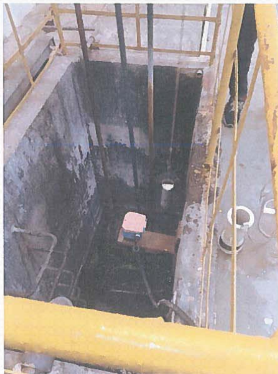
污水处理站进口(★2#)
