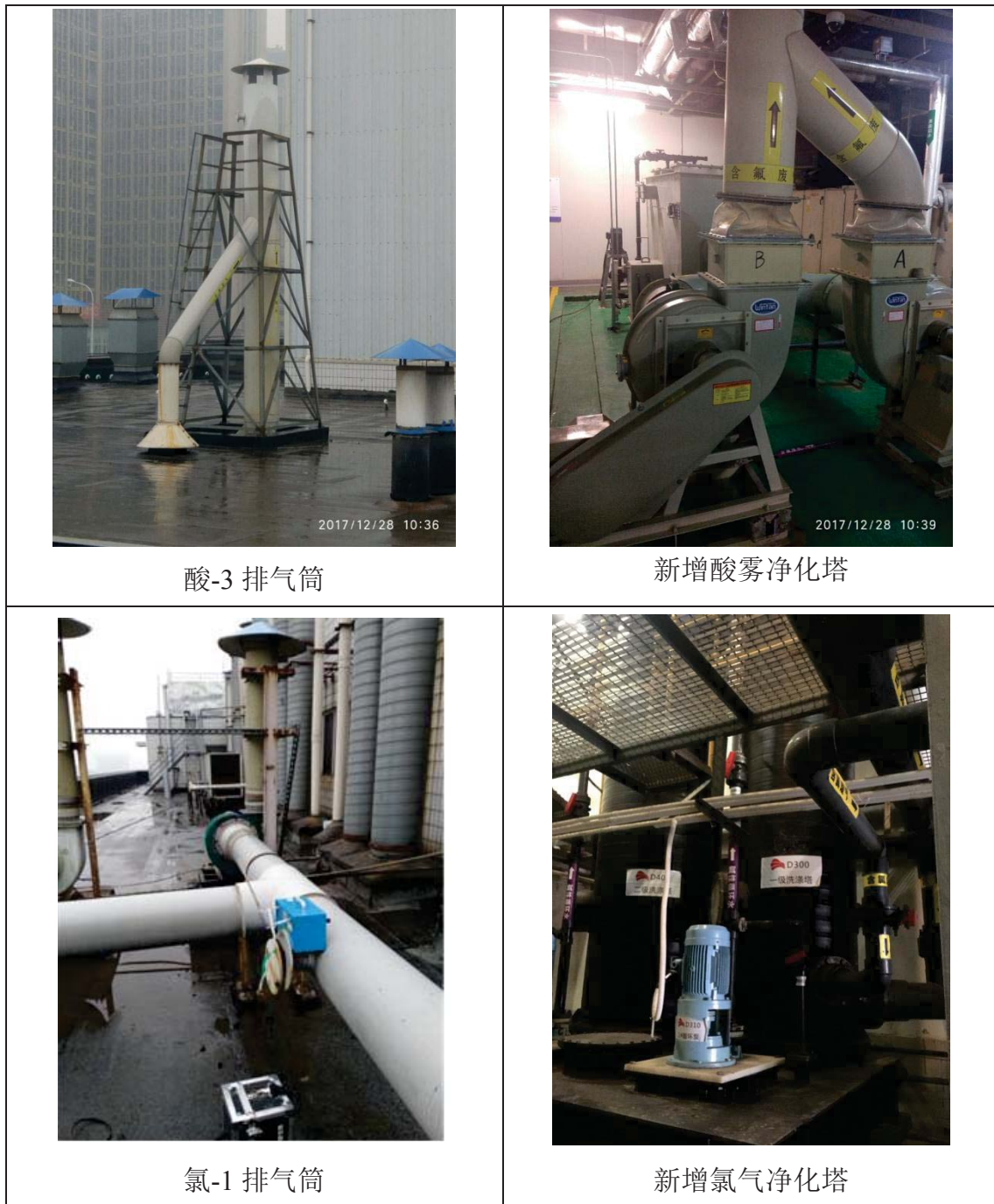
图 4-4 项目废气处理设施
