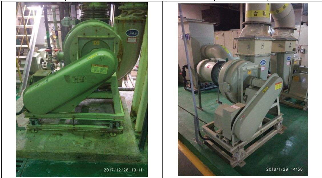
图 4-5 减震器（弹簧）、软连接照片
