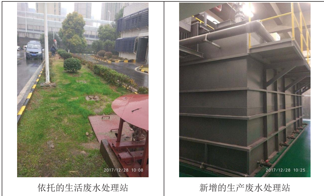
图 4-1 项目废水处理设施
