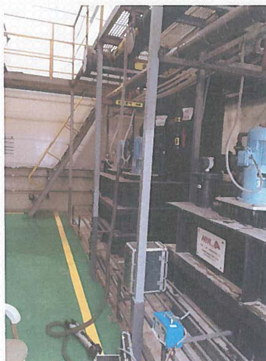
氯-1 排气筒进口(©1#)
