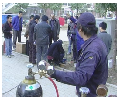
b. 使用瓶装压缩气体作为气吹机动力
